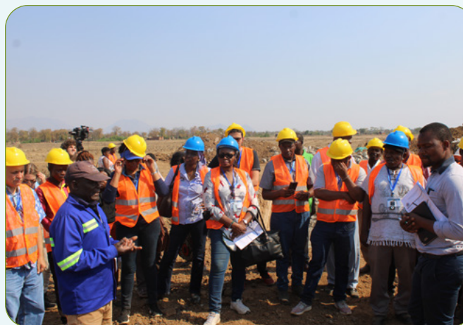
Parties prenantes de RFS visitant le site de construction du système d'irrigation PRIDE pendant l'Atelier d'échanges et apprentissage 2022 au Malawi. Image: ©Felix Malamula, PRIDE Malawi
